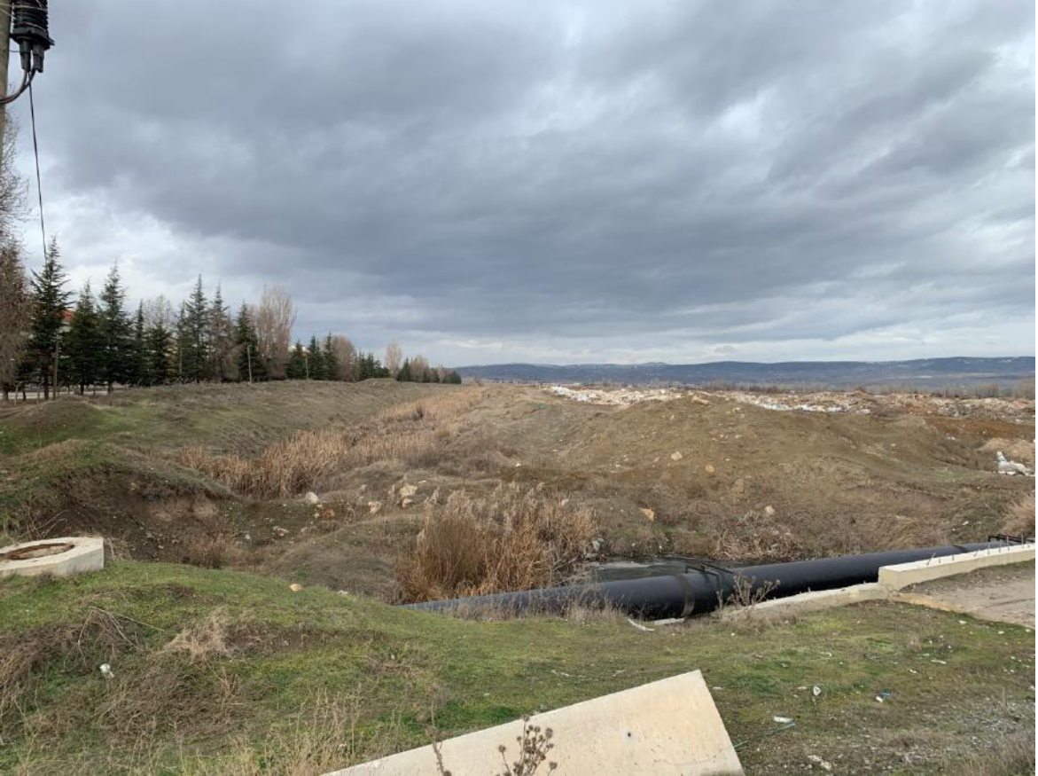
ESTÜ TGB Ek Alanı Kenarındaki Drenaj Kanalı
