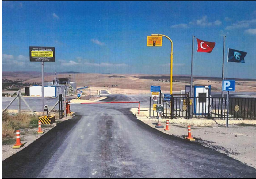
Keskin inşaat ve yıkıntı atıkları geri kazanım tesisi girişi
