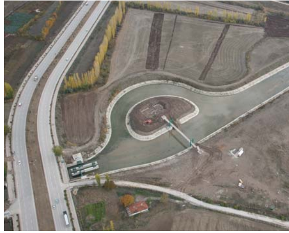
Nuri Bey Ada Geçişi Asma Köprü
