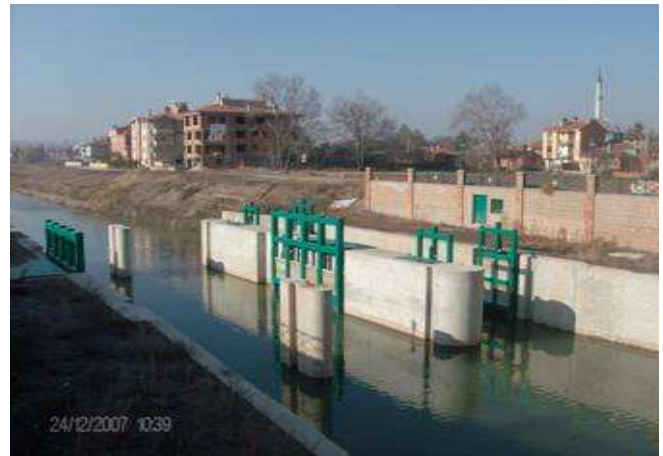
Su Seviye Kontrol Yapısı 1
