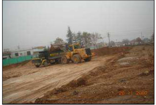
Ihlamurkent Candanel Alt Temel Yapım Çalışmaları
