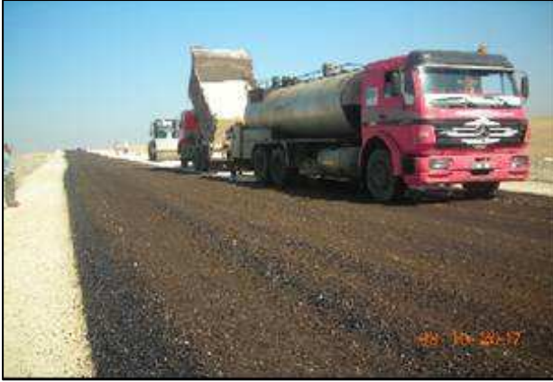
Aşağıcağlan Yolu Sathi Kaplama Çalışmaları
