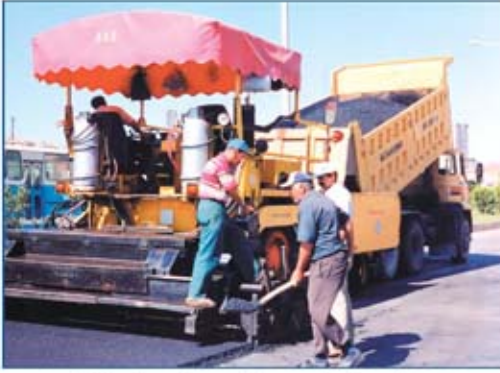
Asfalt çalışmaları modern araçlarla yapılıyor.
