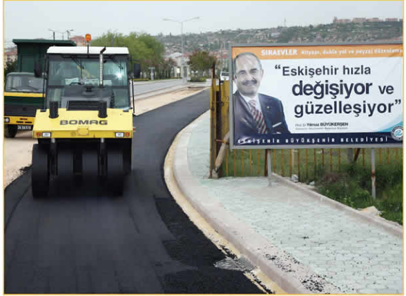
Büyükşehir Belediyesi son iki sene içinde Eskişehir'in dört bir yanında 10'a yakın yeni cadde ve bulvar açtı. Altyapı çalışmaları tamamlanan yolların kenarlarına evcelce olmayan kaldırımlar da yapıyor.
