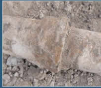
Sağlıksız ve çürümüş olan eski su boruların polietilen tüpü yeni borularla değiştiriliyor.
