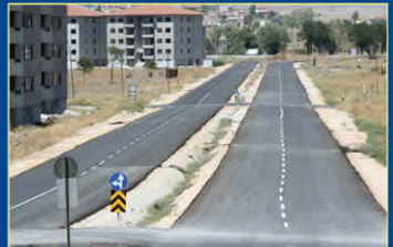
Asfalt kaplama çalışmaları tamamlanan bulvarlarda kaldırım ve refüj düzenlemeleri de yapılacak.
