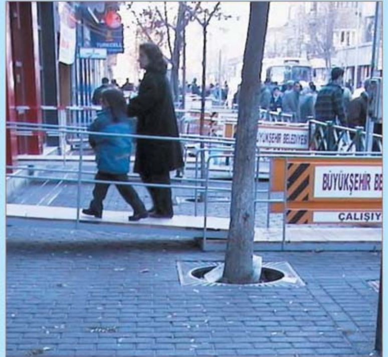
Eskişehir'de ilk defa kullanılan 'iskele' sistemi ile vatandaşlar yapımı devam eden kaldırımlar üzerinde bulunan dükkanlara rahatça ulaşabildiler
